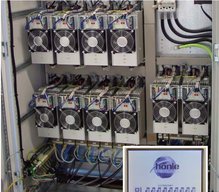
Sonnensimulations-Schaltschrank & Touch-Screen Bedienungsfeld
